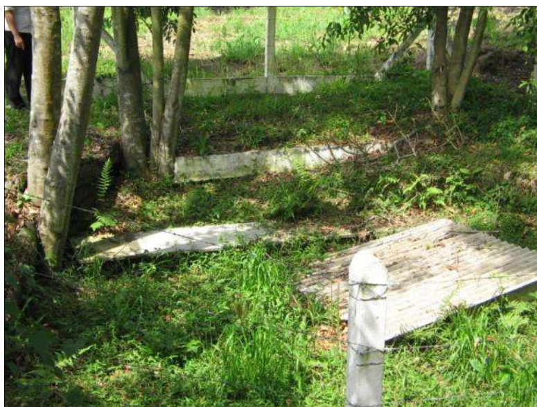
Figura 7.3 - Local da nascente que abastece o poço. Nascente e filtro cobertos.
