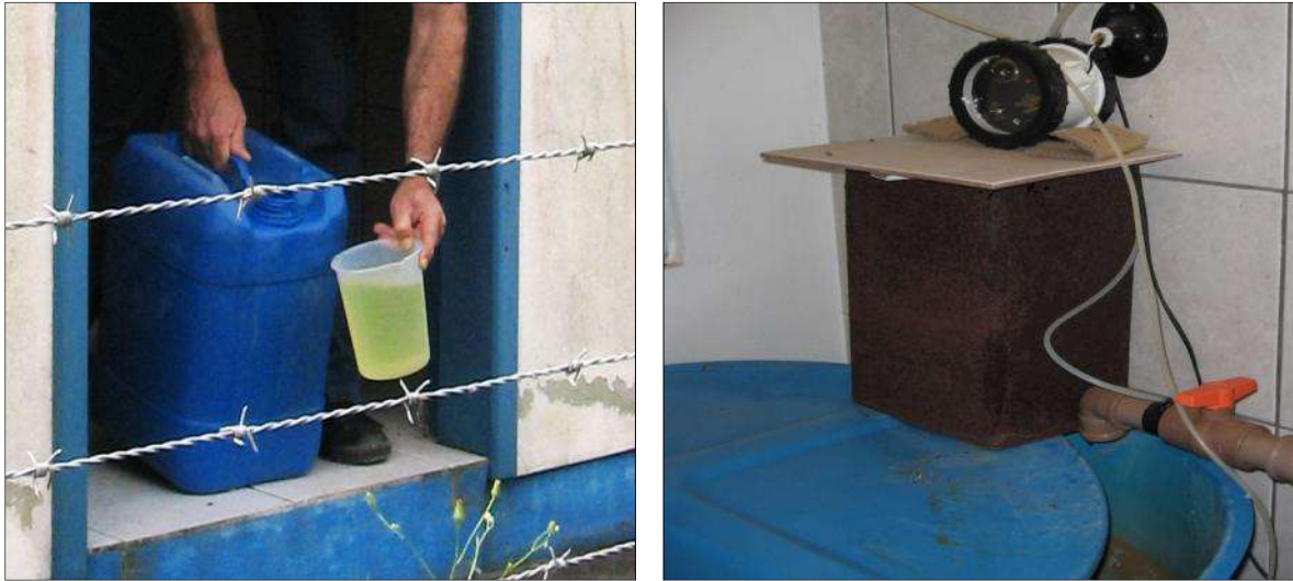
Figura 7.7 - Hipoclorito de sódio em estado líquido e bomba dosadora de cloro.
