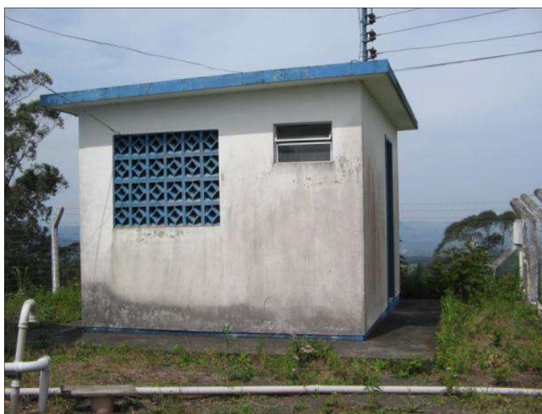
Figura 7.6 - Casa de química da ETA de Belvedere
