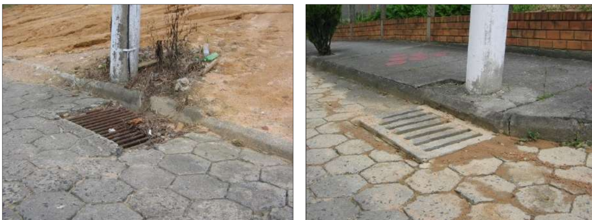
Figura 6.15 – Causas de assoreamento
