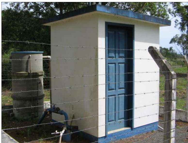
Figura 7.4 - Local de captação no poço e filtro desativado.
