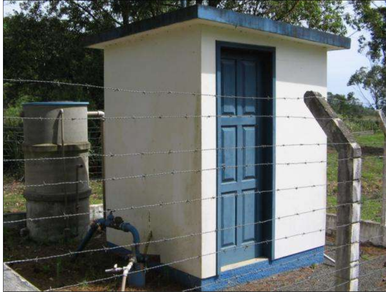
Figura 7.4 - Local de captação no poço e filtro desativado.
